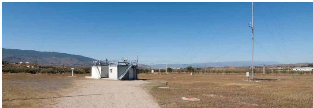
Figura 60. Vista general de la nueva estación radiométrica PSA.
