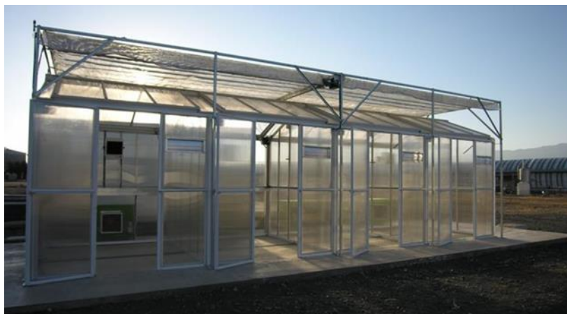
Figura 41. Cámara de cultivo para la reutilización de aguas de riego residuales en cultivos en la PSA.
