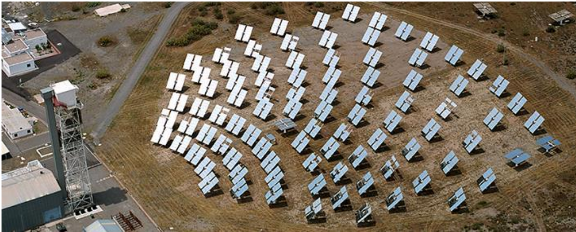
Figura 15. Vista aerea de la instalación experimental SSPS-CRS.
